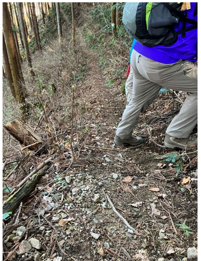
c 地点路面の状況
